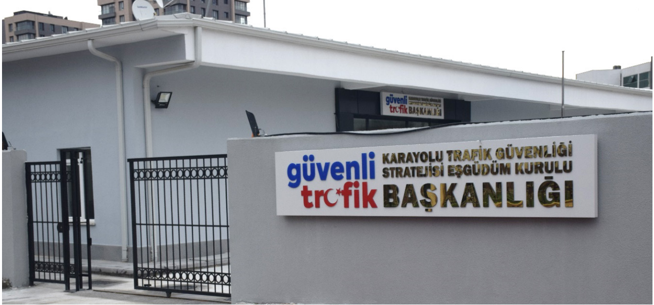
Şekil 2.3: KTGS Eşgüdüm Kurulu Başkanlığı Binası
